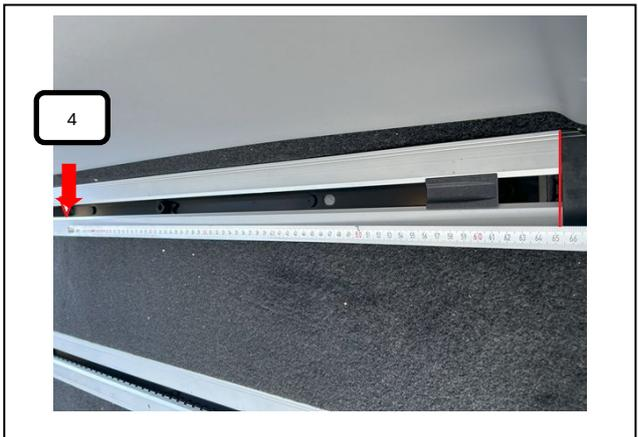
Zollstock am Ende der Bodenschiene (rote Linie) an legen und dann 65 cm messen, an dieser Stelle muss die Gegenplatte für Bodenhalter (Pos. 4) hinein gelegt werden.
